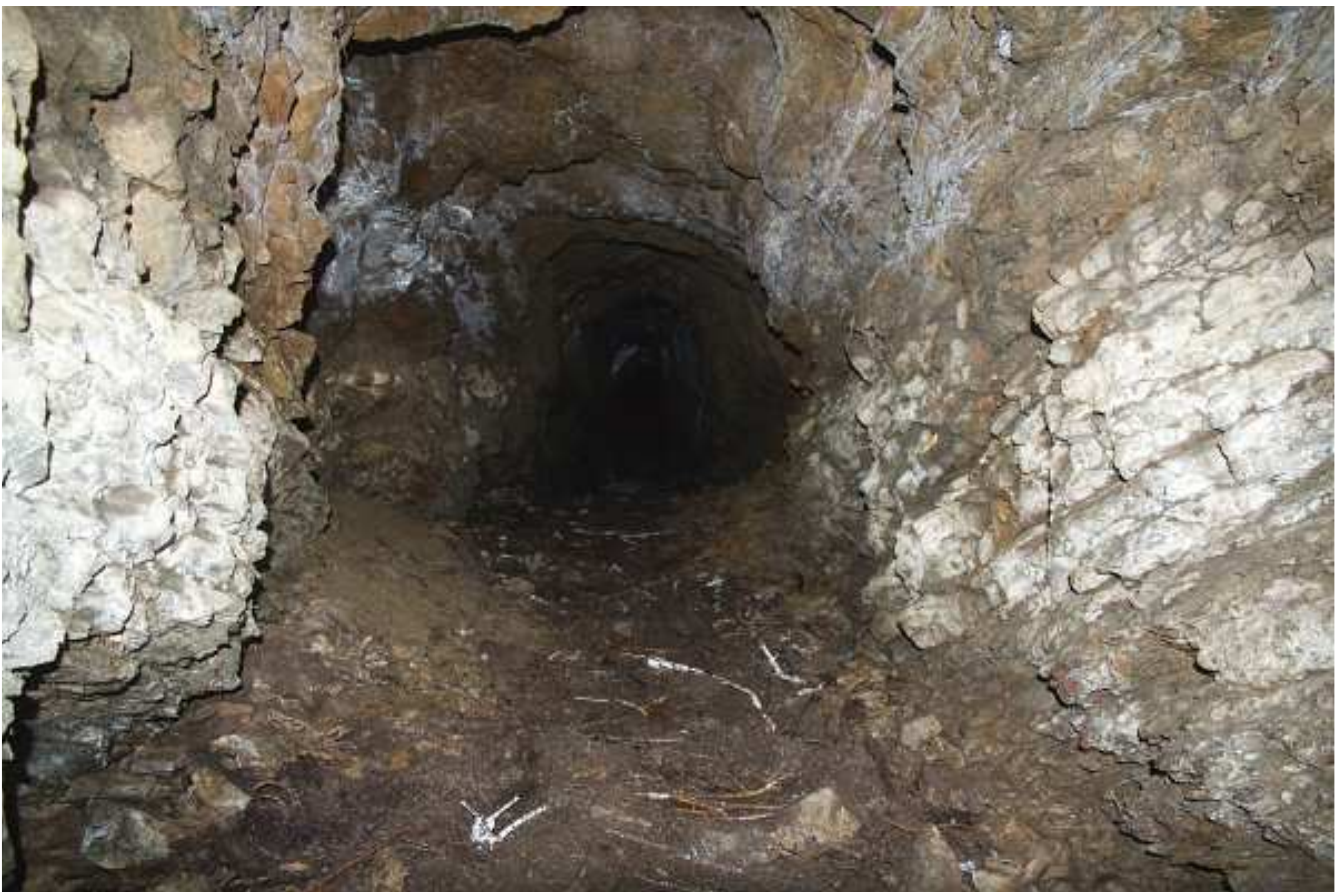
Foto: Odvodňovací šachta
